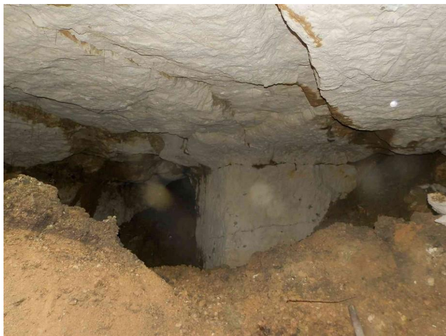
Vue générale de l'intérieur de la cavité de la R10 avant sa suppression
