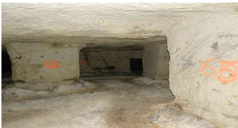
Vue générale de l'intérieur de la carrière du Village. En taches sombres, certaines poches argileuses.
